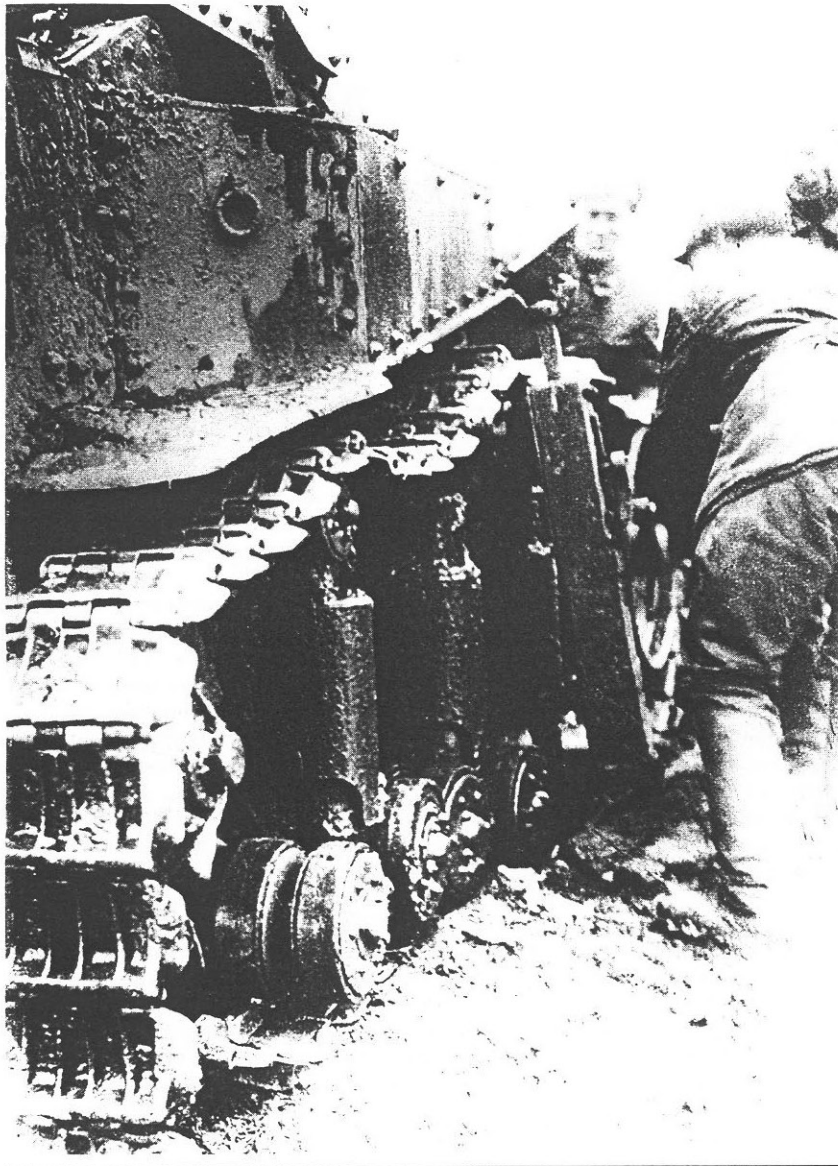
91 Подведение домкрата. (ЦМВС) Tank jacking
