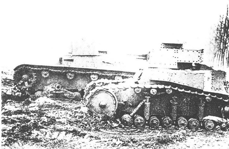
Танк Т-18 с 45-мм орудием без двигателя (с некоторых танков «хвост» демонтировался) T-18 with 45-mm gun. This updated vehicles took part in initial period of the Great Patriotic war
